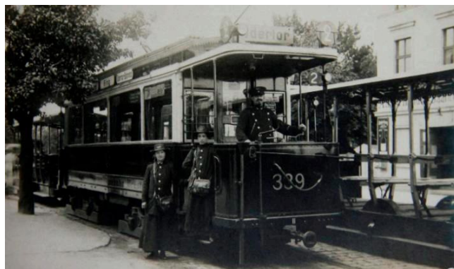
Tramwaj linii nr 2 - stacja końcowa przy Parku Południowym . W tle fragment fasady dawnej gospody „Pod Kasztanami” (źródło: www.dolny-slask.org.pl)
